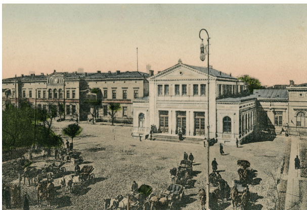
Dworzec Kolei Warszawsko-Wiedeńskiej w Sosnowcu, proj. Henryk Marconi, 1859 r., zbiory Stacji Muzeum
