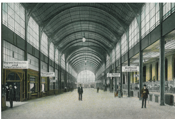
Wnętrze dworca we Wrocławiu, 1857 r., zbiory Stacji Muzeum
