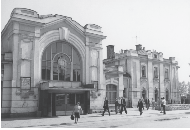
Dworzec w Bochni po przebudowie, ok. 1908 r., Stacja Muzeum
