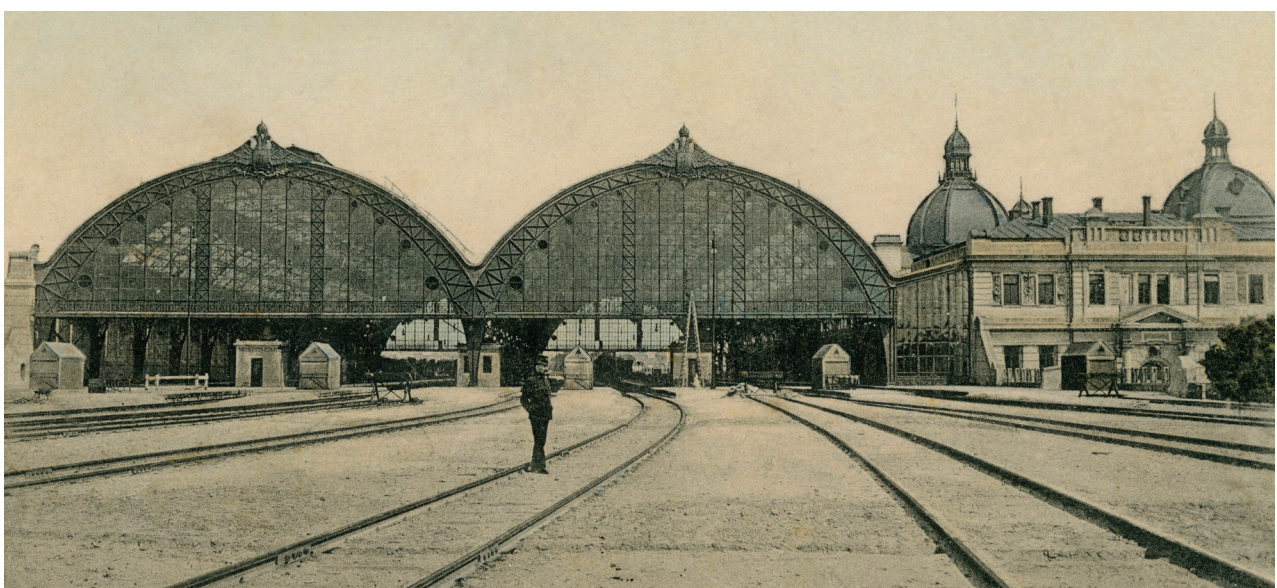
Przeszklone konstrukcje hal peronowych dworca we Lwowie, proj. Władysław Sadłowski, 1904 r., zbiory Stacji Muzeum
